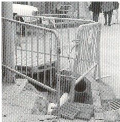
Les obres que es fan a Vic a causa del gas.
