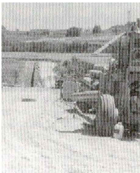
Les obres estan en marxa.
