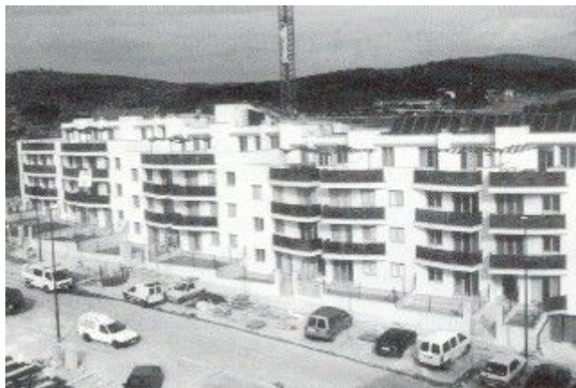
Aquests apartaments de Sitges incorporen el sistema de ventilació SAV.
