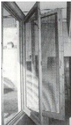
El sistema de finestres conegut com a Sistema Acústic Ventil·lat (SAV).
