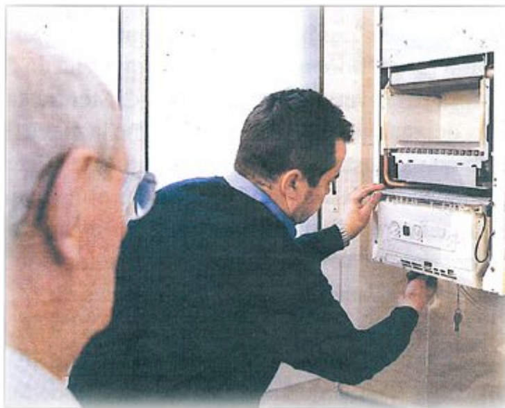
Un operari realitza el manteniment d'un escalfador
